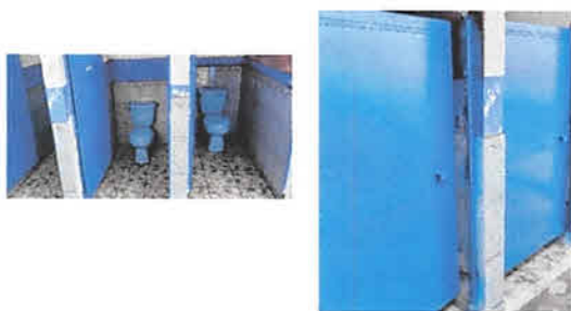
Foto1: Finalización colocar azulejo en la pared, piso antideslizante en sanitarios y 3 puertas de metal, finalizado
