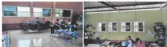
Foto 2: Ventanas PVC de la parte trasera de 4 aulas, finalizadas
