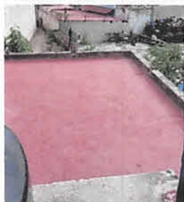
Foto 3: Impermeabilización de loza de la cocina por humedad y filtración de agua, finalizada
