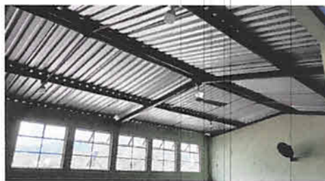
Foto 4: Sustitución del sistema eléctrico, en todas las aulas, finalizado
