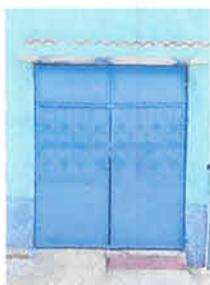
Foto 5: Reparación de portón de ingreso (lijado, pintura y bisagras) medida de 2.5*2mts. Finalizado
